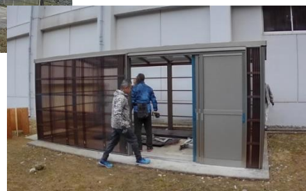
・改修後新しくなった倉庫
